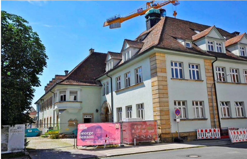
Außenansicht vor Sanierungsbeginn
